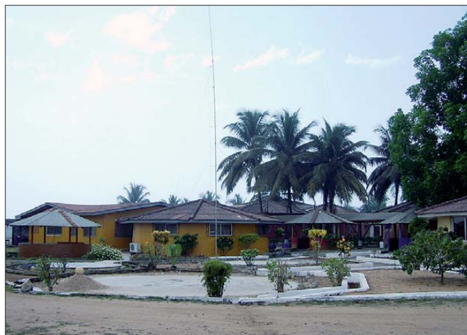
Die „Ersatz“-Hotelanlage bot zum Glück ausreichend Platz zum Aufbau der Vertikal-Antennen.
